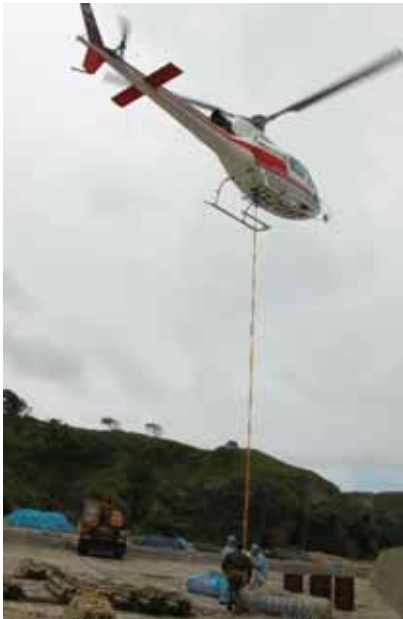
写真-11 7/2 文吉湾資材吊り上げ作業
