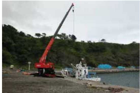
写真-10 7/2 文吉湾資材陸揚げ作業
