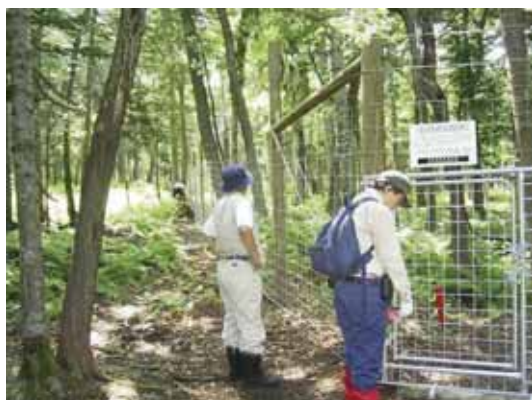
写真-13 標識取り付け作業
