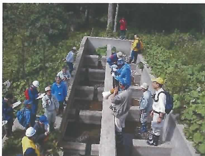
平成17年9月21日 イワウベツ川支流のピリカベツ川 No.8、10 谷止工（森林管理局）に 設置された魚道にて
