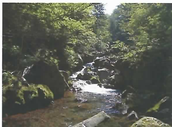
治山ダム上流部はプールになっている。
