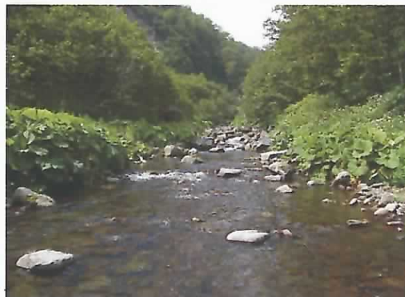
治山ダム上流部の土砂堆砂状況。
