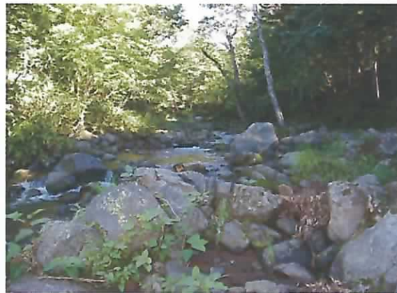
治山ダム上流部の土砂堆砂状況。
