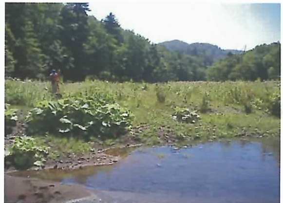
治山ダム上流部の土砂堆砂状況。
