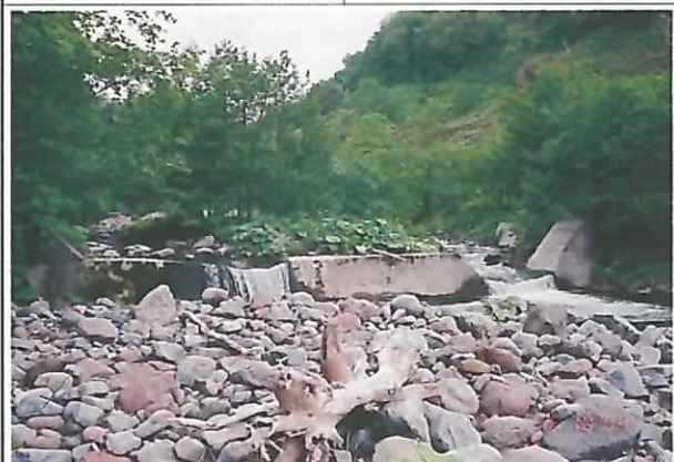
下流より望むNo.3床固工。
