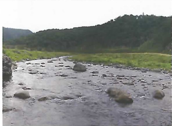
上流堆砂状況
