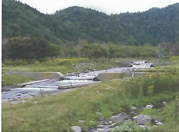
下流よりNo.1床固工全景
