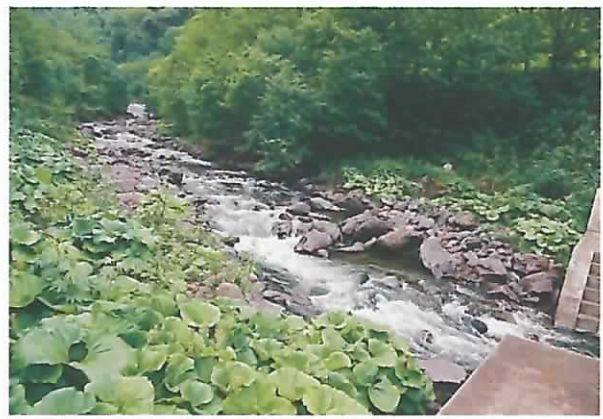
治山ダム上流部の土砂堆砂状況。
