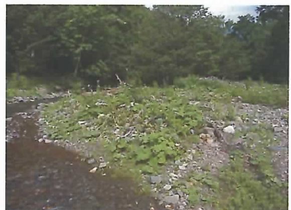
治山ダム上流部の土砂堆砂状況。
