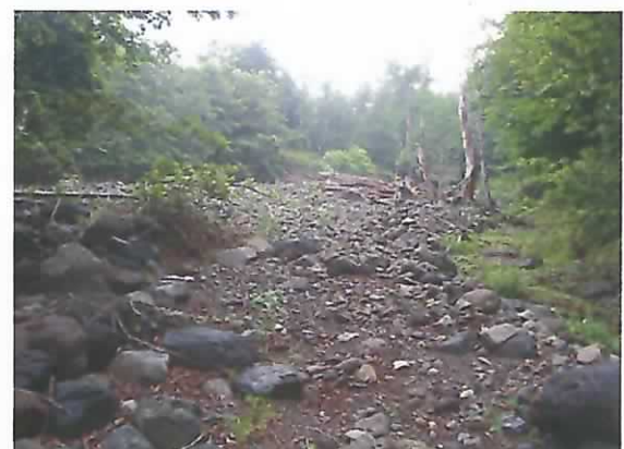
治山ダム上流部の土砂堆砂状況。
