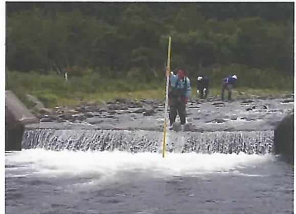
下流部プール水深状況
