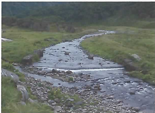
下流より魚止め全景
