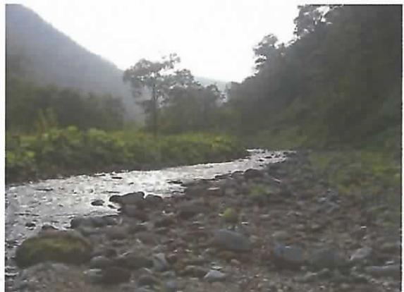
治山ダム上流の土砂堆砂状況。
