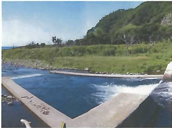
下流プール状況
