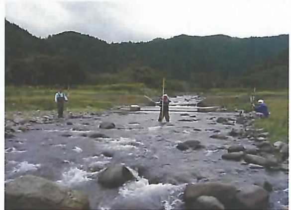
下流より望むNo.1床固工
