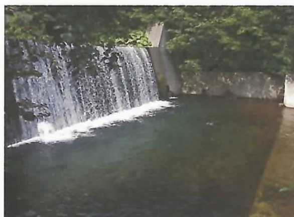
治山ダム上流部のプール状況。
