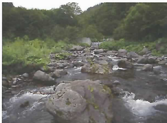
治山ダム上流部の土砂堆砂状況。
