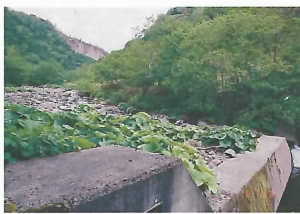
治山ダム上流部の土砂堆砂状況。
