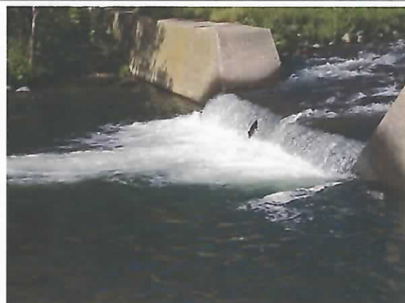
ダム放水路落差状況
