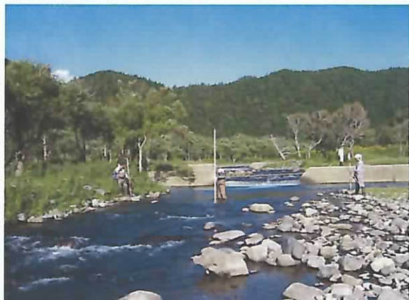
下流より望むNo.2床固工
