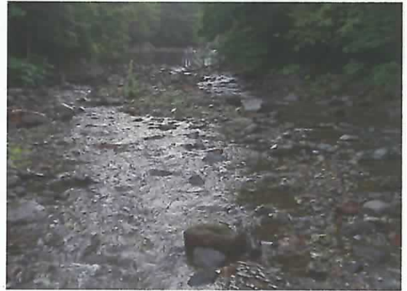
治山ダム上流部の土砂堆砂状況。
