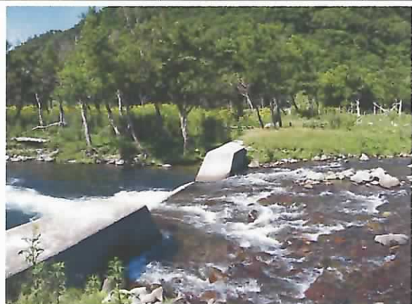
上流堆砂状況
