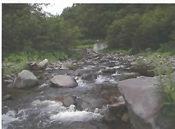
治山ダム上流部の土砂堆砂状況。
