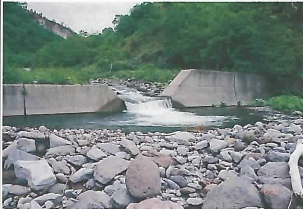
下流より望むNo.4床固工。
