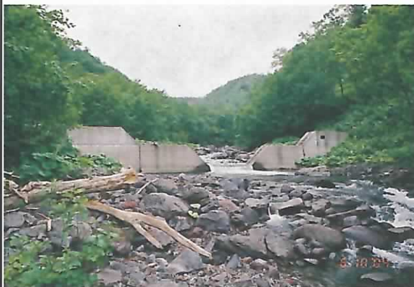
下流より望むNo.6床固工。
