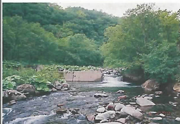
下流より望むNo.2床固工。
