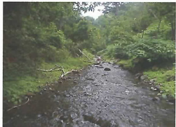
治山ダム上流部の土砂堆砂状況。
