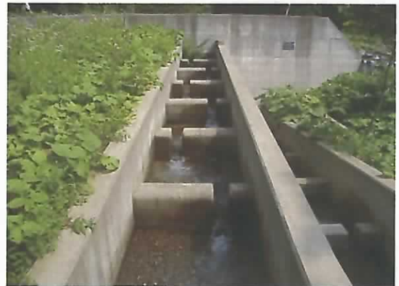
治山ダム右岸の魚道。
