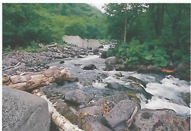
治山ダム上流部の土砂堆砂状況。
