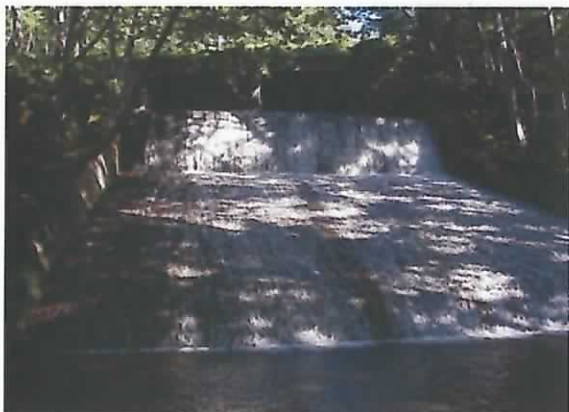
ボックスカルバート直下の落差工。
