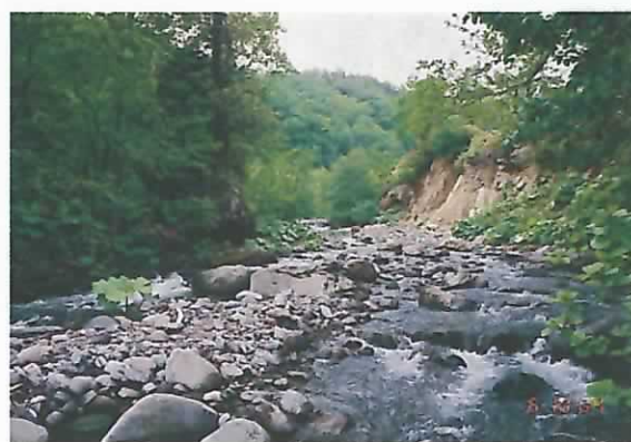
治山ダム上流部の土砂堆砂状況。
