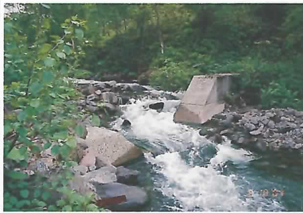
下流より望むNo.5床固工。
