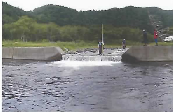
下流より望むNo.3床固工
