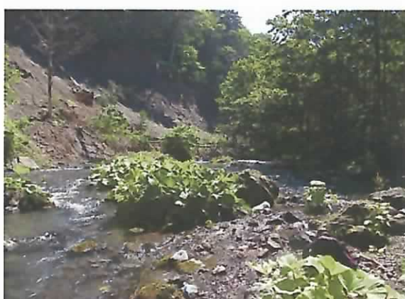
治山ダム上流部の土砂堆砂状況。
