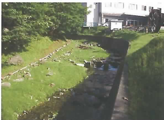
流路工起点付近の状況。右奥は、ホテル地の涯。
