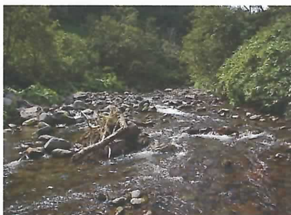
治山ダム上流部の土砂堆砂状況。
