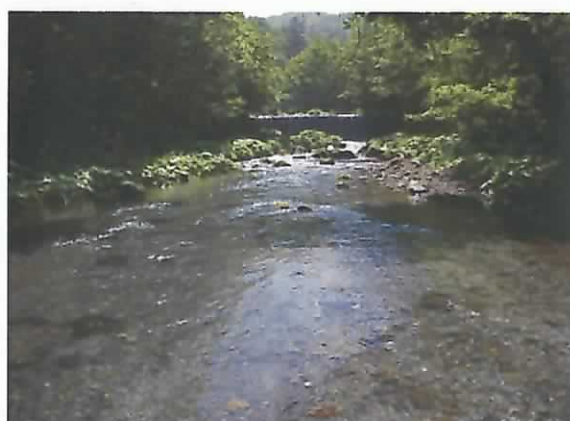
治山ダム上流部の土砂堆砂状況。
