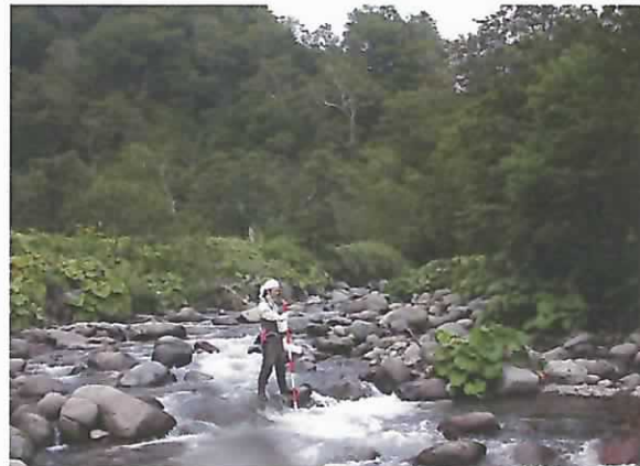
治山ダム上流の土砂堆砂状況。
