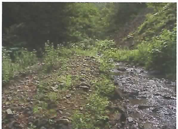
治山ダム上流部の土砂堆砂状況。
