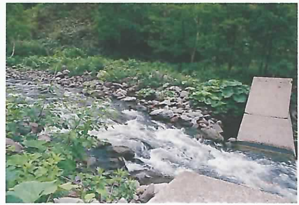
治山ダム上流部の土砂堆砂状況。
