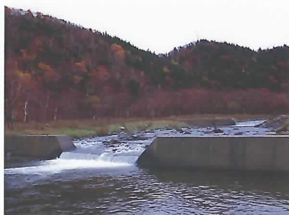
下流より望むNo.2床固工放水路
