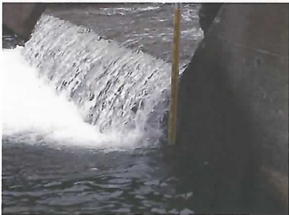
ダム放水路落差状況
