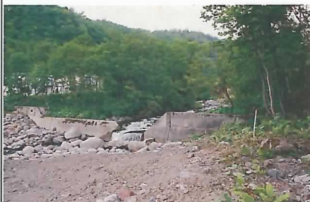
下流より望むNo.1床固工。
