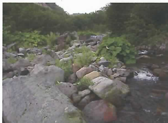
治山ダム上流部の土砂堆砂状況。
