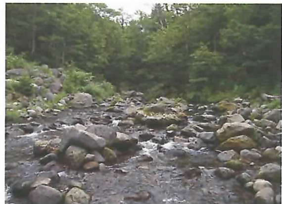
治山ダム上流部の土砂堆砂状況。
