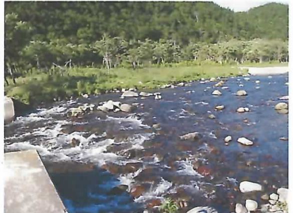
上流堆砂状況
