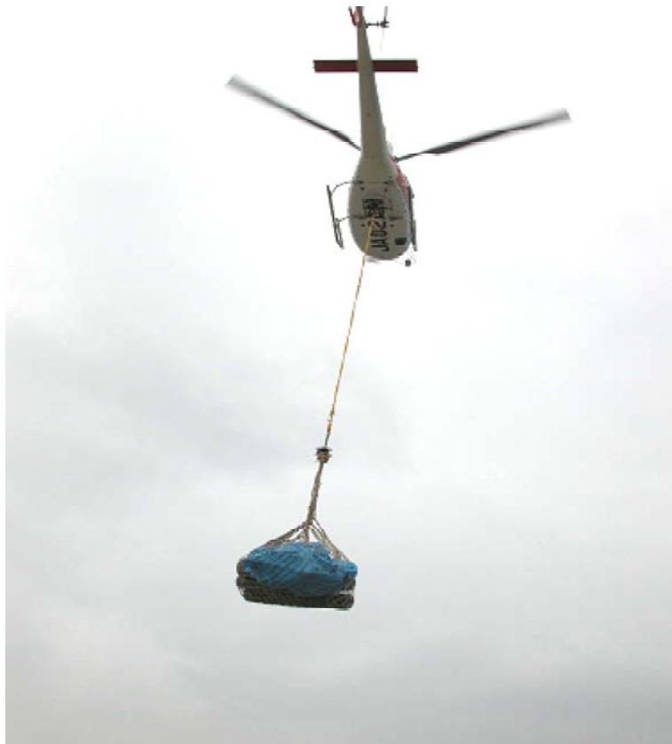
写真 1 3 林内入口へ資材運搬
