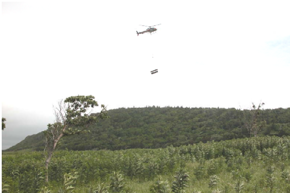
写真 1 4 資材運搬状況
