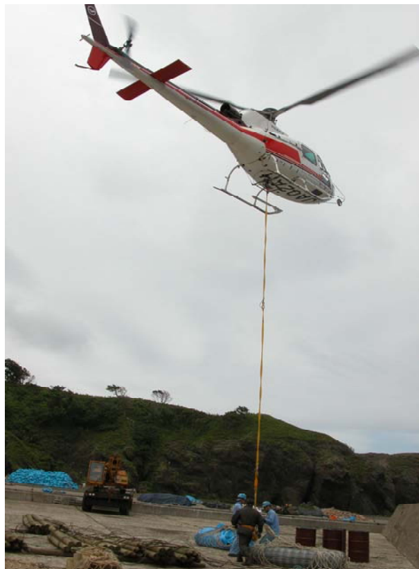
写真1 2 文吉湾資材吊り上げ作業
