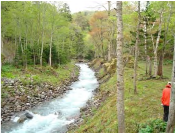
赤イ川No.12 鋼製えん堤上流 (H25/6/5)
