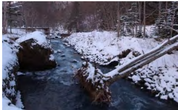
赤イ川No.12 鋼製えん堤上流の左岸決壊状況 (H25/12/24)
