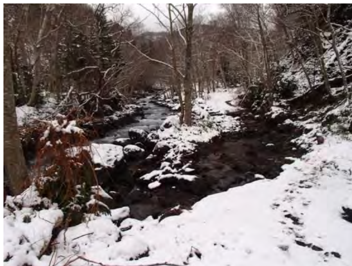
赤イ川左岸の作業道決壊状況（H25/12/3）
