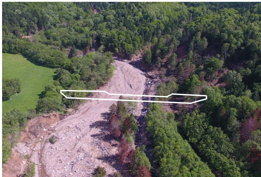
2号床固工 着手前
