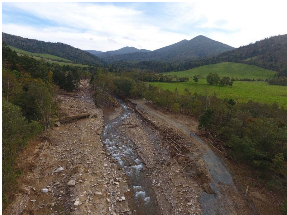
1号床固工 着手前
