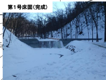
1号コンクリート谷止工 L=45.00m H=5.50m V=373.9m 3
