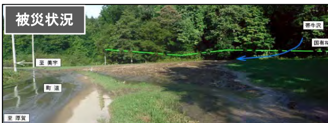
全景(被災状況)
