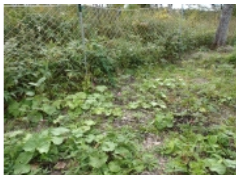
「設置した防鹿柵」
