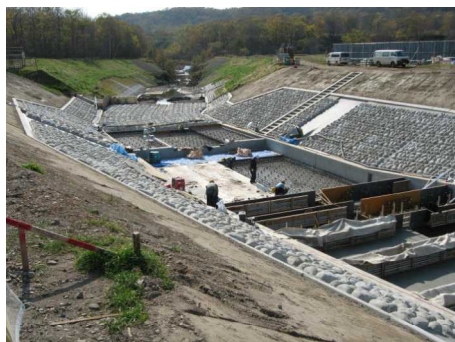
久著呂川土砂流入対策箇所
