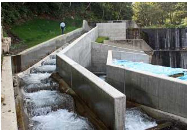
治山ダムに魚道工を新たに設置（羅臼町・民有林）
