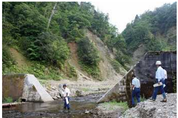
治山ダム切り下げ工箇所（標津町・国有林）
