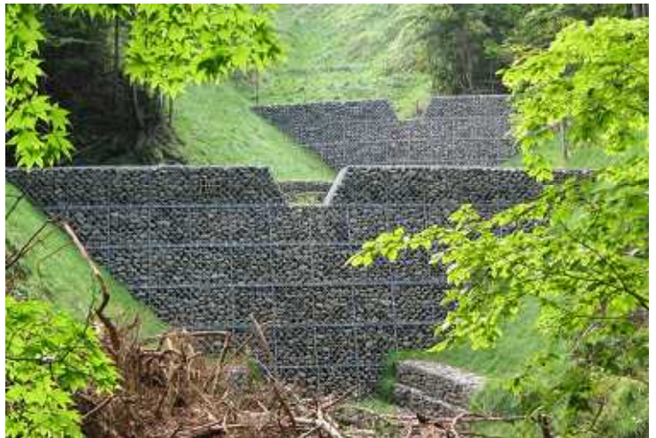
水源地域を保全するための治山事業実施箇所（白糠町）
