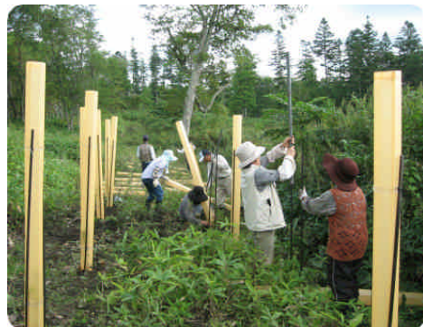
ヘキサチューブの設置 ↑
