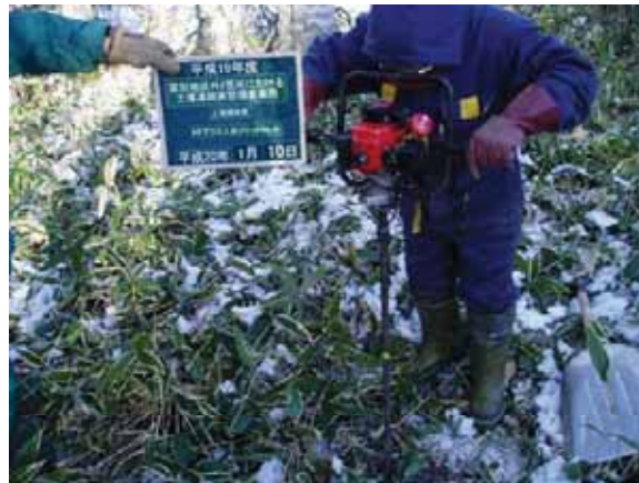
凍結深計設置 No.8
