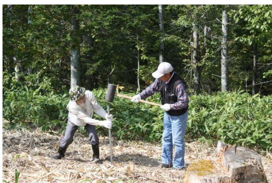
杭打ち(頭に注意！)
