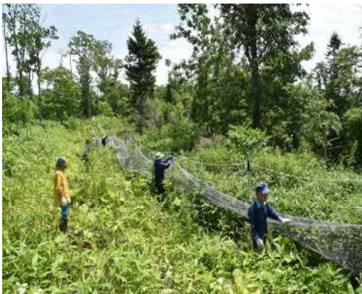
食害防止網設置作業
