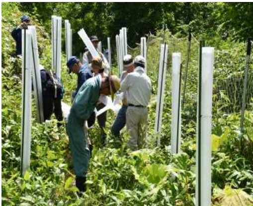
ツリーシェルター設置作業
