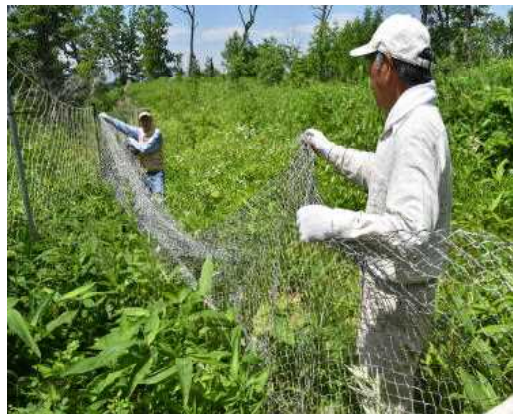
食害防止網設置作業
