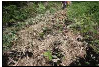
写真-3 粗朶束設置の写真(左:尾根筋側端と中央に1列設置、中央:全体的に粗朶束を埋設、右:無設置)
