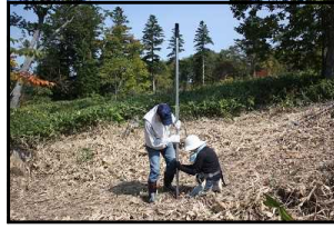
アンカーに支柱(2m)を被覆
