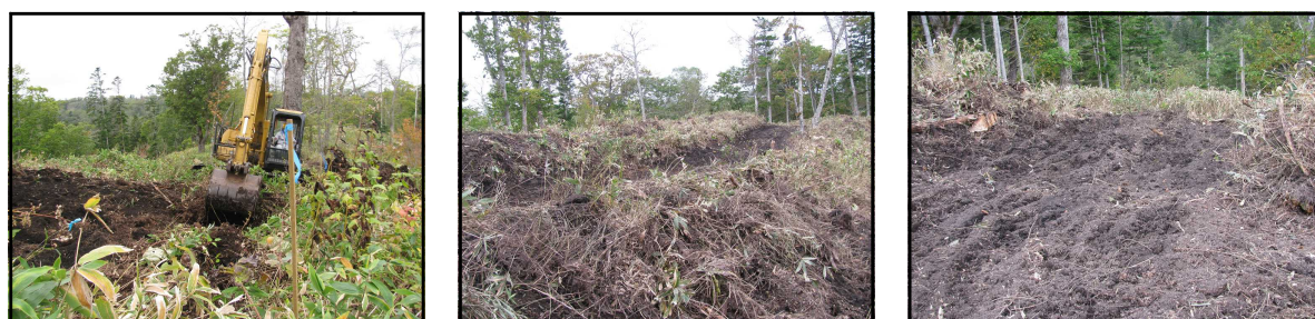
写真-4 地表処理の実施状況(2007年10月)
