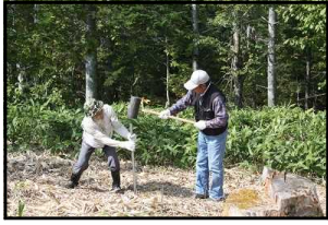
支柱アンカー打ち込み (地下部 50cm、地上部 50cm)
