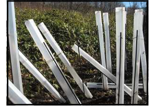
写真-1 シェルターの転倒
