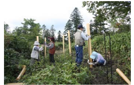
ヘキサチューブの設置
