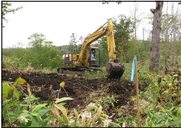
写真12 地表処理の作業状況(2009)
