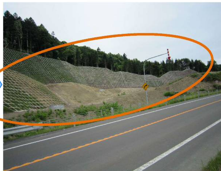
工事完成(平成25年7月3日撮影)
