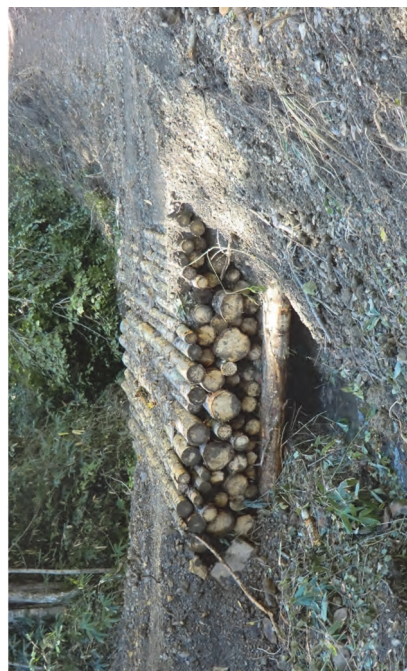
空知森林管理署の洗越工(事業修了後撤去)
