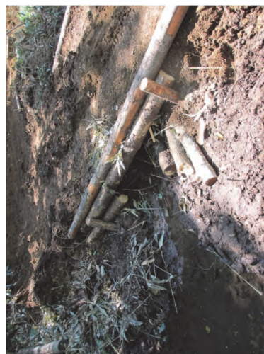
玉石等が出なかったため、丸太開渠設置 事業終了後は撤去する
