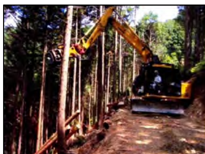
急峻な地形での作業風景
