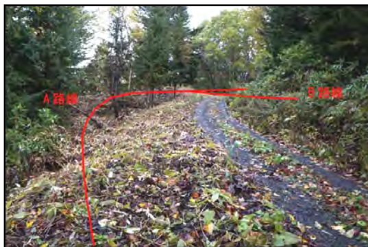
分岐箇所での改善のため既設森林作業道を修正して利用した例
