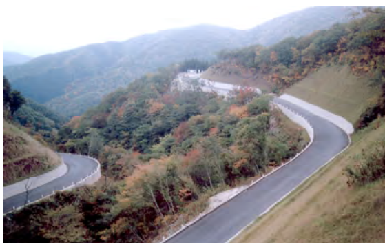
1 車線 1 級林道 幅員=5.0m 道路構造令における 3 種 5 級に相当
