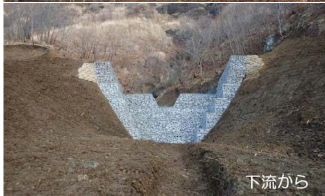
↑桃岩荘の裏に設置した床固工
