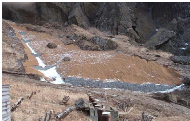
↑桃岩展望台下の土留工と植生マット
