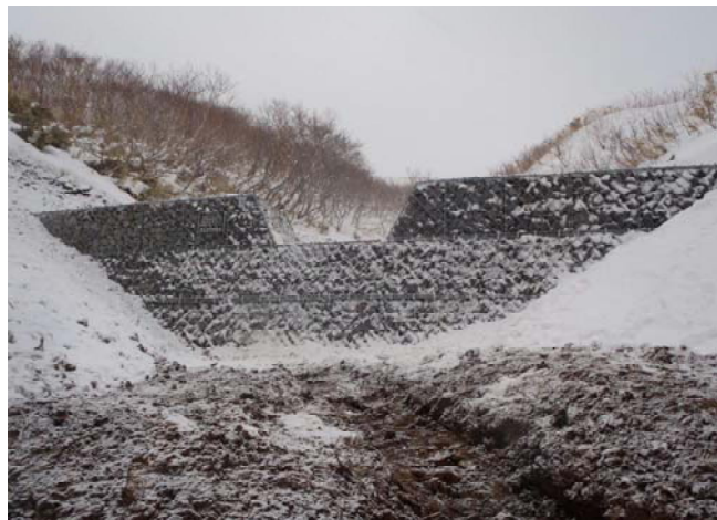
↑歩道沿いの谷止工
