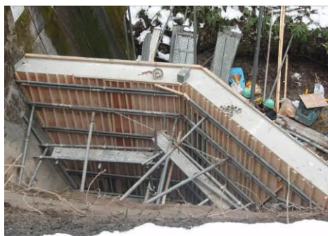
トドマツ型枠の使用状況
