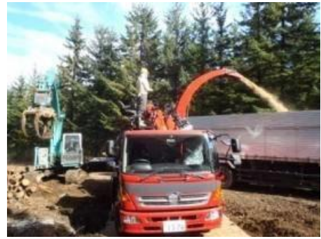
林地未利用材の現地チップ化
