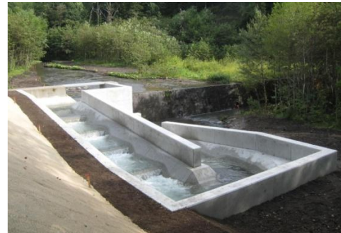
改良前の治山ダム(上)と完成した魚道(下)
