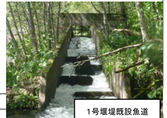
1号堰堤既設魚道
