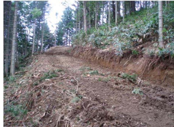
写真 4 作業路(表土ブロック積み工法)
