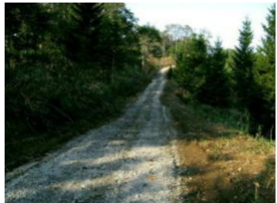
作業道作設状況
