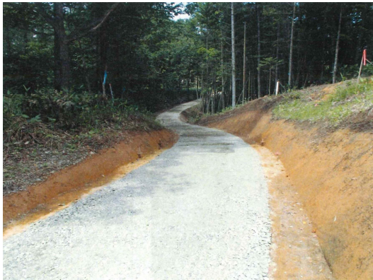
作設した林業専用道（2085林班線）
