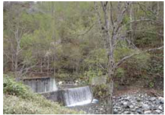
治山工事の一種、溪間工
