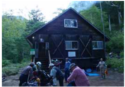
幌尻山荘(レクリエーションの森施設敷)
