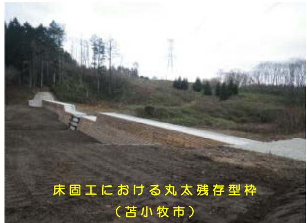
床固工における丸太残存型柵
