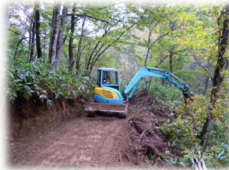
低コストで崩れにくい 森林作業道
