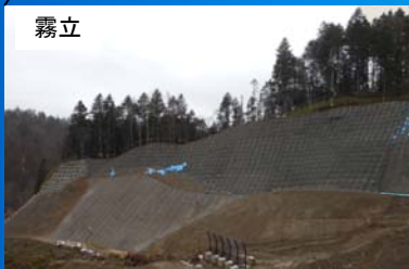
平成24年度施工の災害復旧工事箇所
