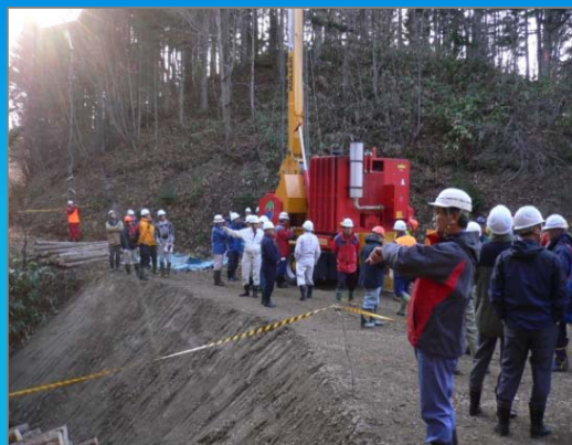
架線系システム導入現地検討会
