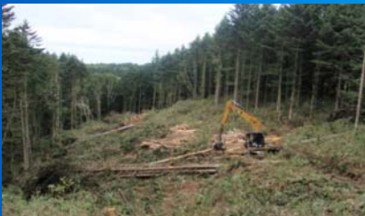
平成24年9月1日 ハーベスタによる造材作業 (伐採幅 33m)
