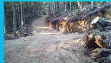
ミニバックホウ0.20㎡で作設した森林作業道 6月29日上川南部署
