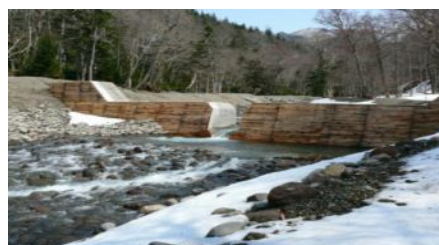
工事後の様子
