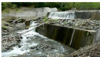
工事前の様子
