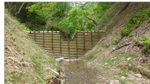
治山工事における間伐材利用 （十勝西部署）
