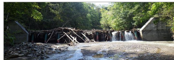
スリットダムによる流木の捕捉(十勝西部署)
