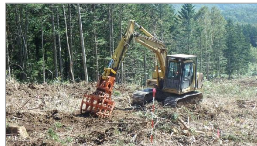
地拵作業（上川中部署）
