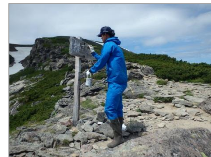
グリーン・サポート・スタッフ (注) による展望台案内板の補修 (上川中部署)
