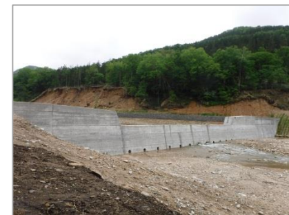
治山工事（十勝西部署）
