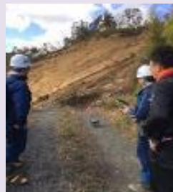
ドローンによる被災林道調査
