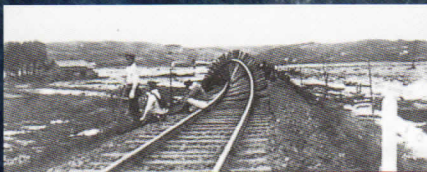
泥流の通過によってめくり上がった鉄道線路
