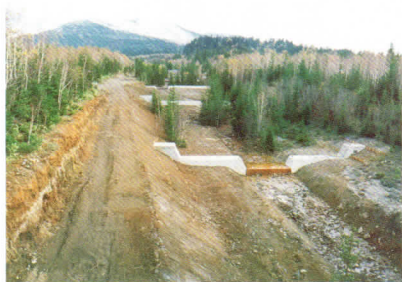
硫黄沢治山ダム[床固工](平成4年施工)
