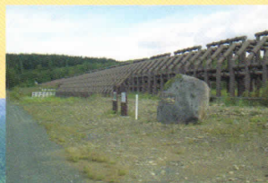
北海道施工の砂防ダム(2号透過ダム) ※写真提供:北海道 旭川土木現業所
