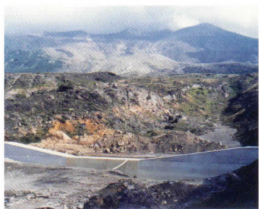
工事中の埋設型治山ダム(平成2年)
