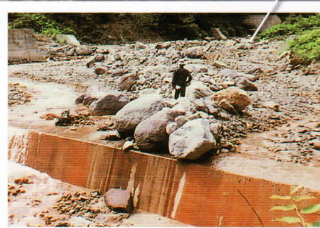
低ダムで止まった巨石。土石流のヘッド(流れの先頭)だったものと思われる
