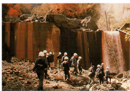
治山ダム(高ダム)の天端に残る巨石 1973(昭和48)年撮影
