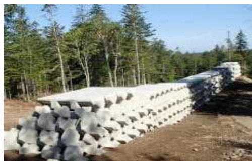
ブロック導流堤 十勝岳(美瑛町)
