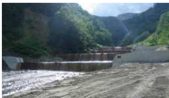
床固工 黒岳沢(上川町)
