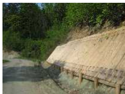
視線誘導を兼ねた木製法面工 (内大部林道)
