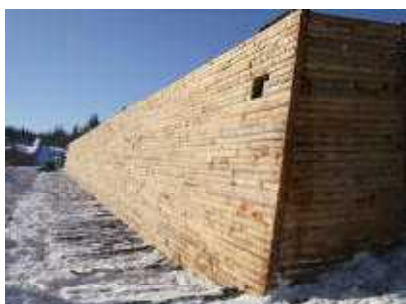
化粧型枠を使用した導流堤 (硫黄沢)
