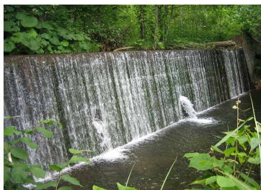
土砂をせき止める堰堤
