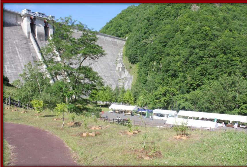
「定山溪ダム下流園地に植えました。」 「完成です！」
