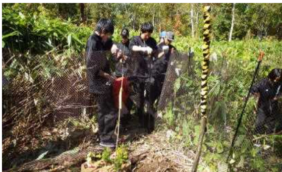
効果てき面の防護柵の設置
