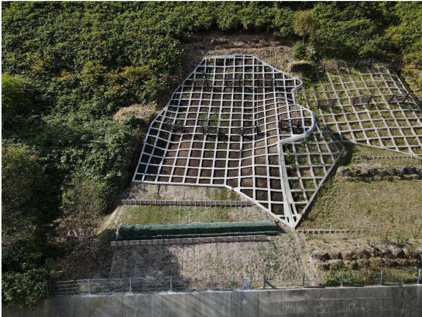
港3丁目治山工事（稚内市）
