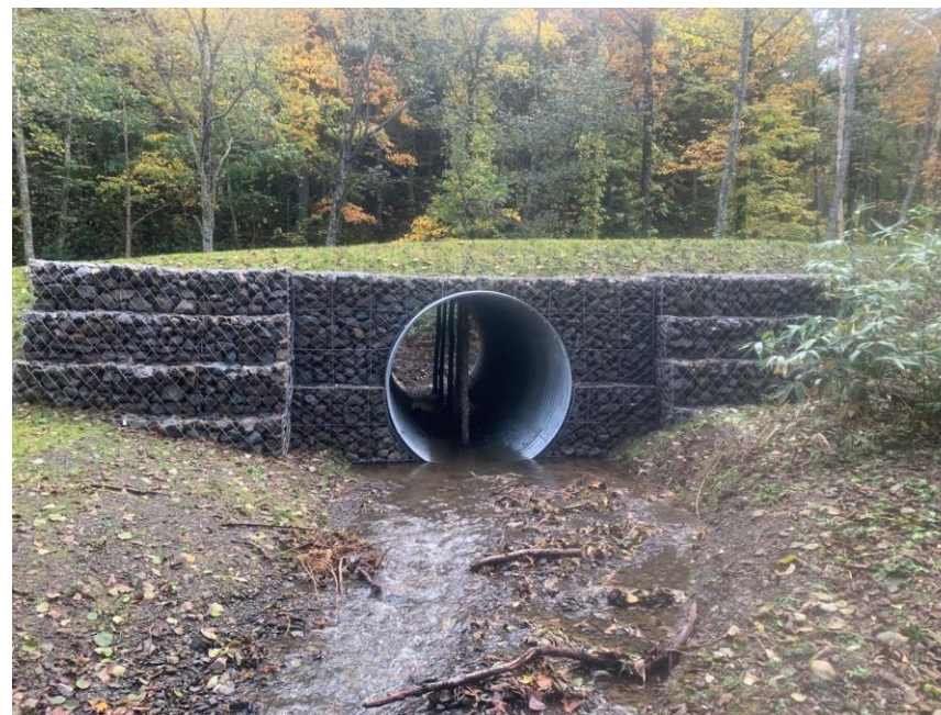
17線沢林道改良工事（浜頓別町）
