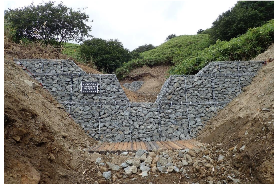
東浦地区治山工事（稚内市）
