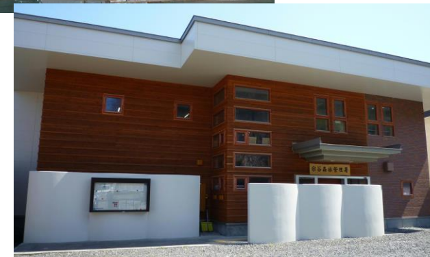
北海道産材を使用した 宗谷森林管理署庁舎 (平成30年1月竣工)
