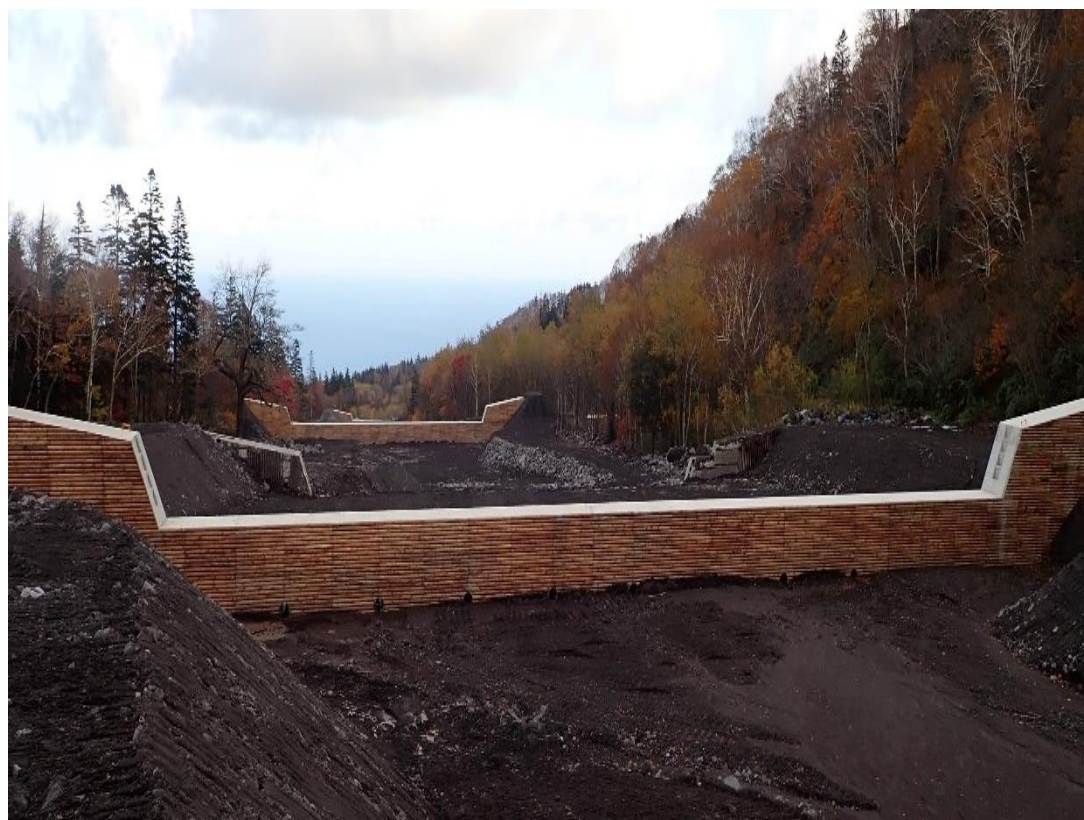
間伐材を使用した丸太残存型枠【治山工事】 (令和3年施工 利尻富士町)
