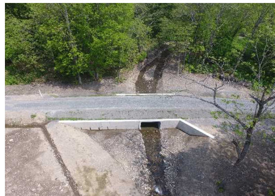
林道災害復旧工事（幌加内町政和）
