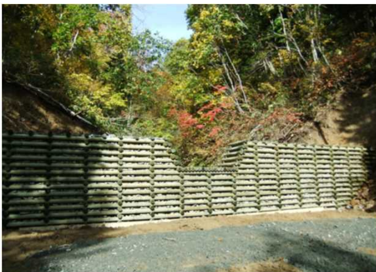
校倉式治山ダム（幌加内町字朱鞠内）
