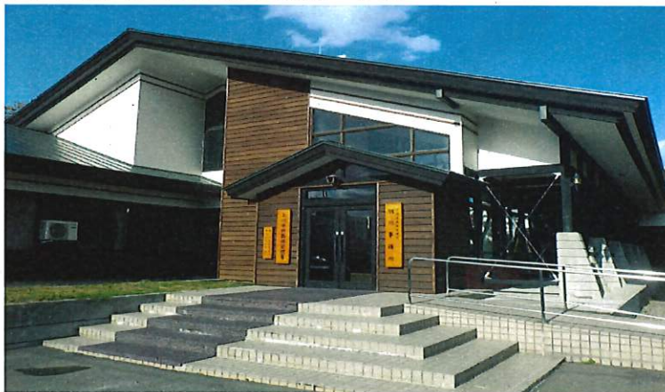
耐震工事後の庁舎
