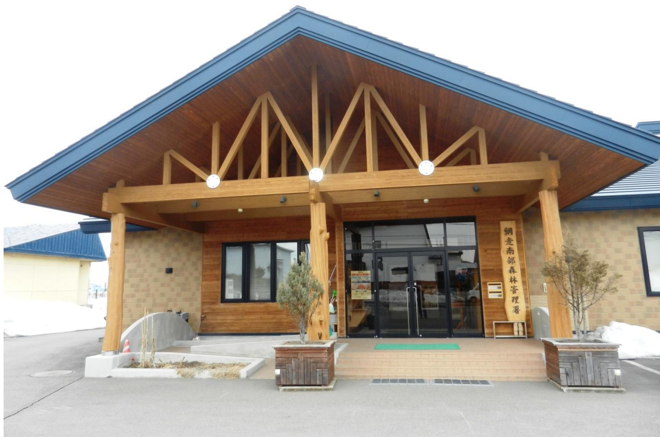
網走南部森林管理署庁舎(正面玄関側)
