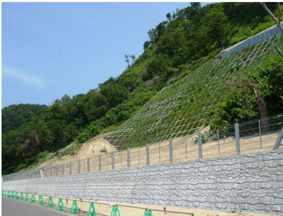
地滑りを防止する山腹工事(ウトロ地区)
