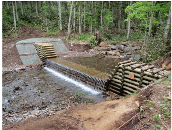
土砂の流出を防止する溪間工事(斜里地区)
