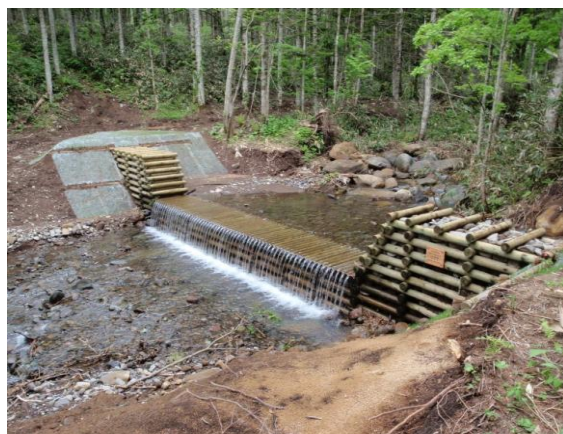
土砂の流出を防止する溪間工事(斜里地区)
