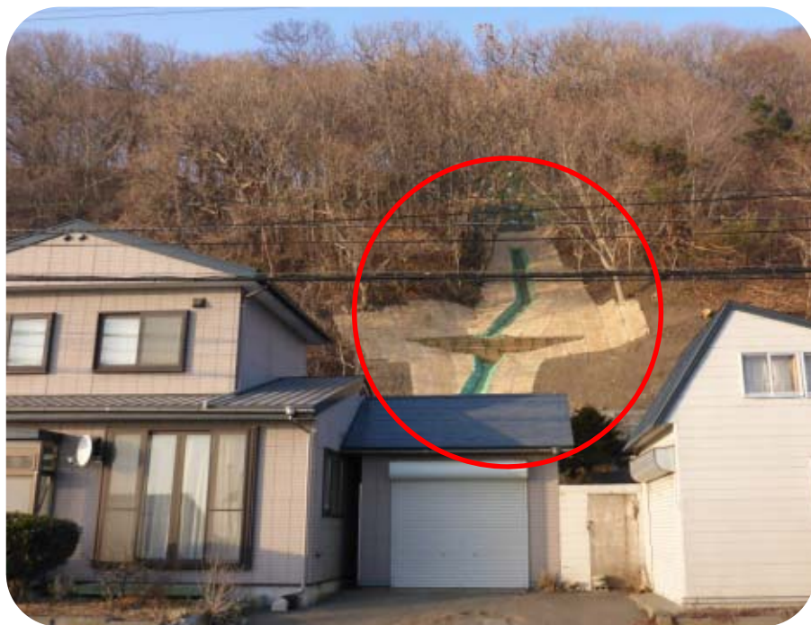
(平成25年12月 工事完成時)
