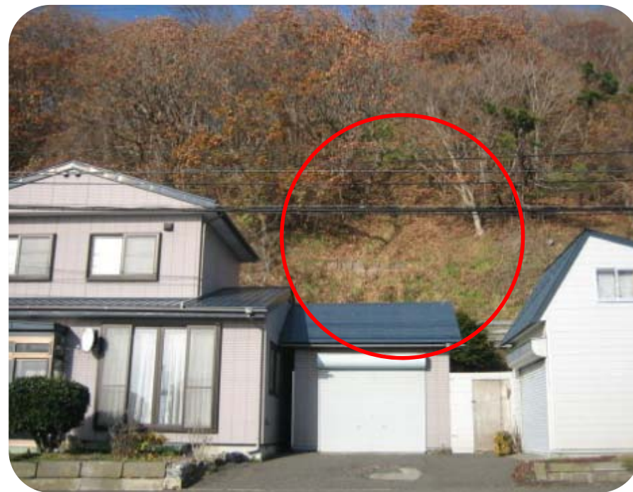
(平成28年4月 完成後2年経過)
