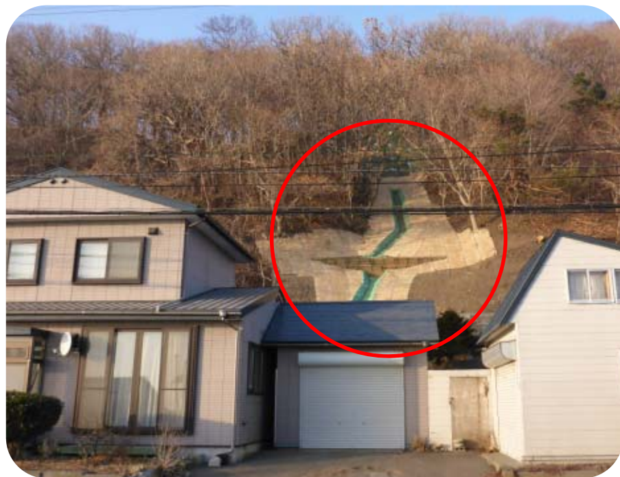
(平成25年12月 工事完成時)
