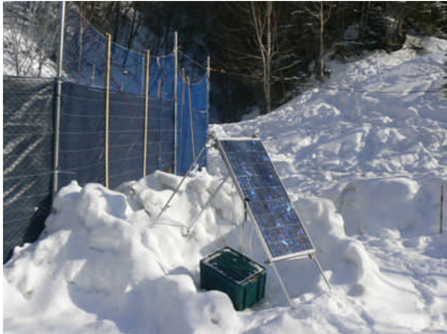
ソーラーパネルとバッテリーユニット。
