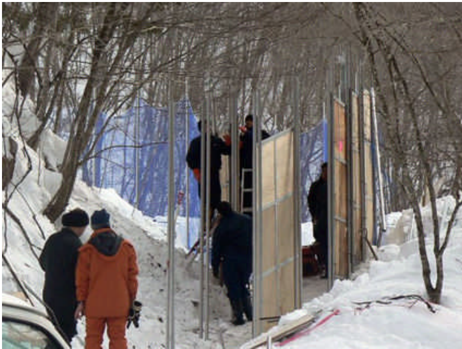
追い込み区設置工事中の写真
