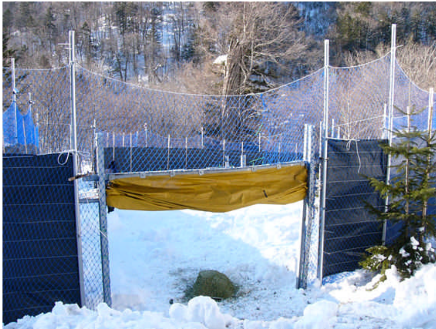
自動扉（メインゲート）の様子。写真は開口時を囲いワナ外側から望む。開くと地上 160cm の開口部となる。
