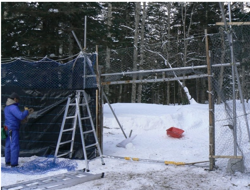
図-2.16 ゲートを設置している様子。束石の構造が見える。支柱を立て、網を張り、目隠しのシートを展開していく様子。
