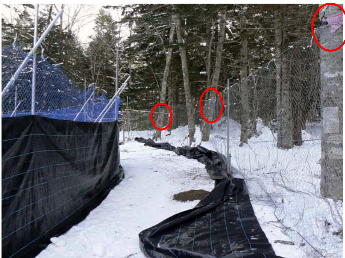
図-2.17 立木を用いた施工（円内は立木を支柱として利用している）。
