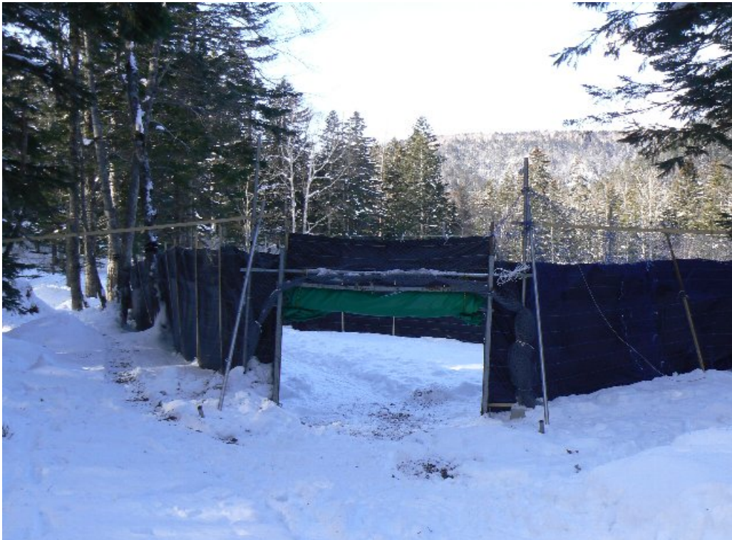
図-2.14 落下扉部分を、ワナの外部から見た様子
