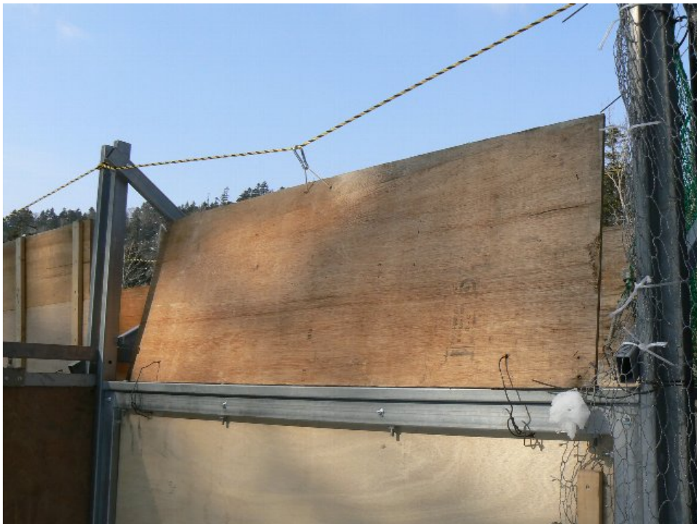
図-2.9 開閉式の天井の様子（開放時）
