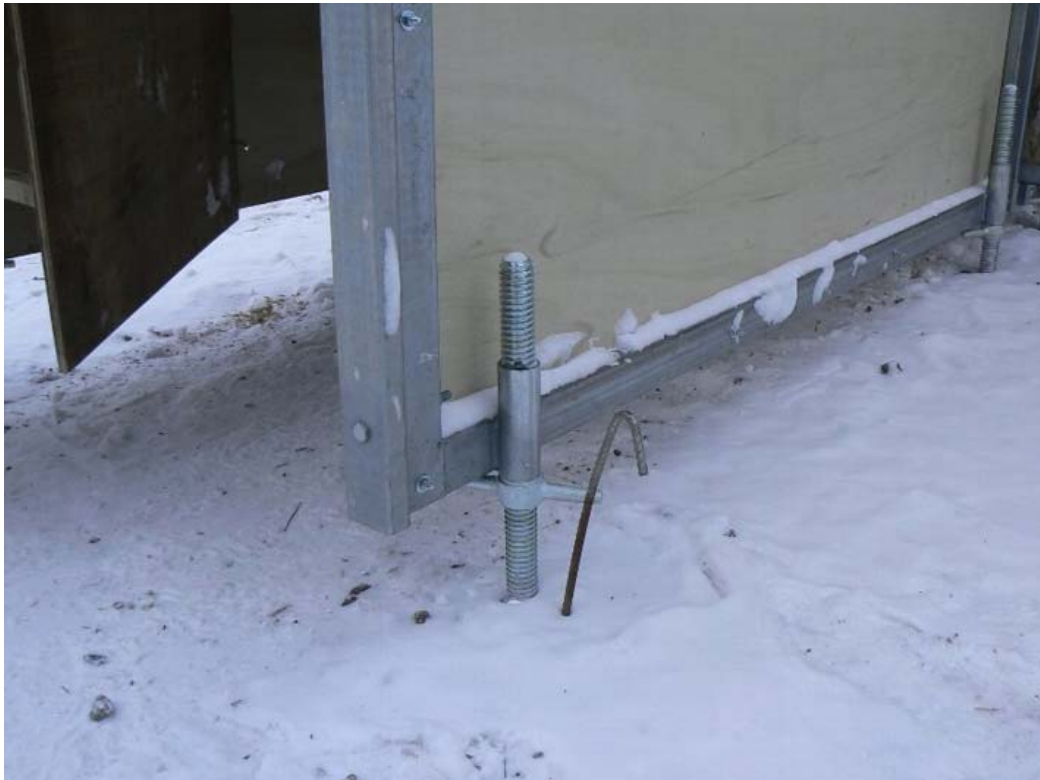
図-2.10 追込みユニット下部のジャッキ部分。レベル出しが容易。
