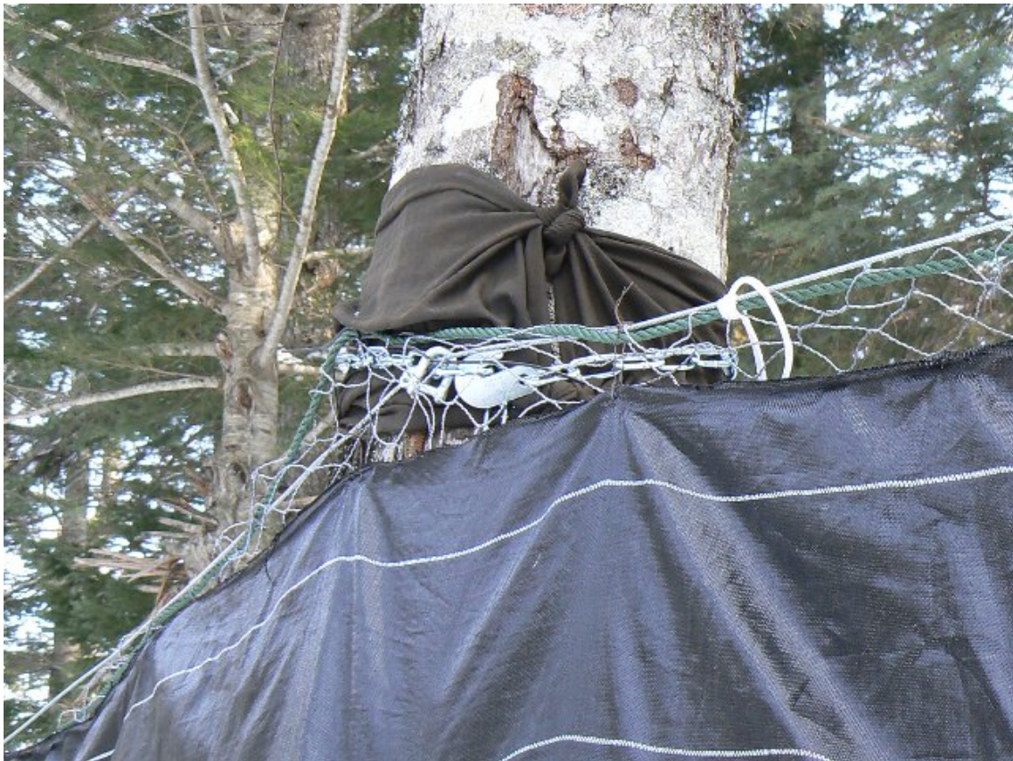
図-2.18 立木への配慮と養生の様子 ウエス等によって樹皮を保護
