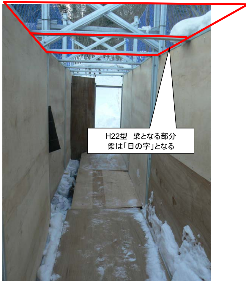
図-2.11 追い込み部の梁の構造 (H22 型)
