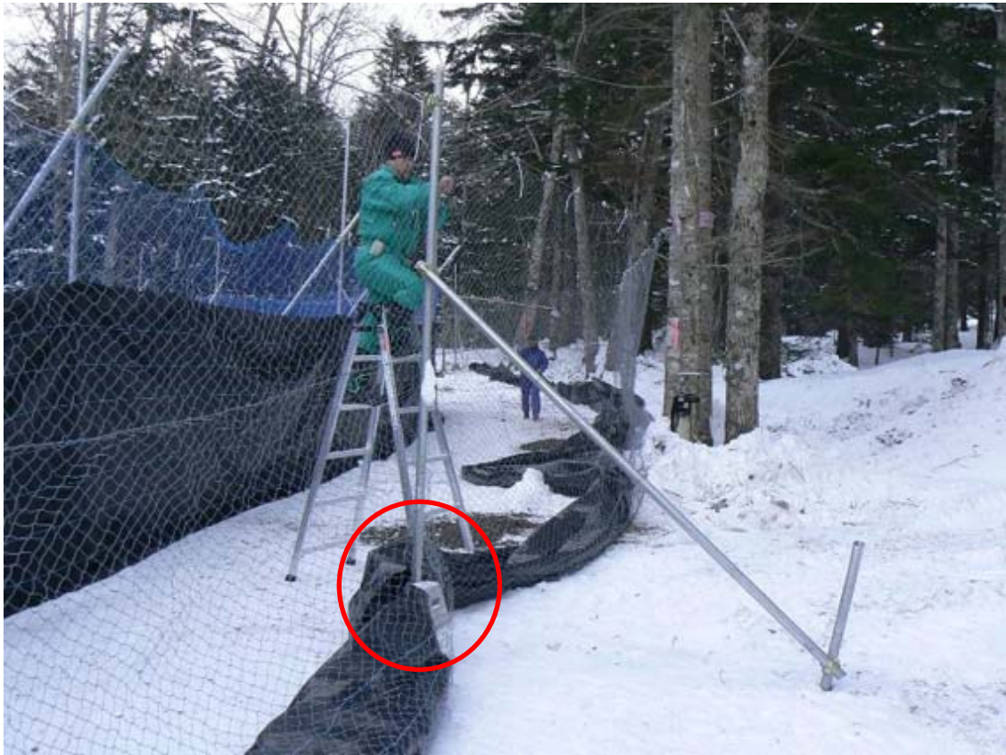
図-2.19 支柱の設置状況（束石（円内）と控え杭の様子）
