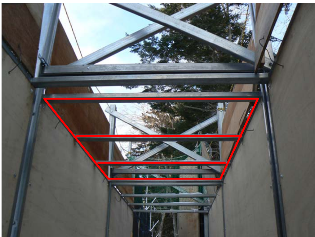
図-2.12 H23 型の梁の構造
